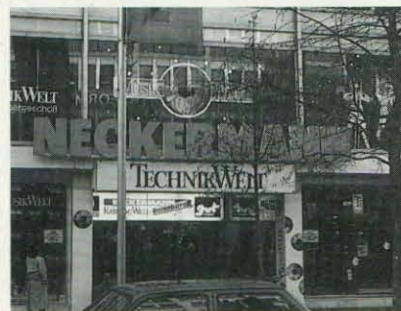
Zeil 41, am Rand der Fußgängerzone
