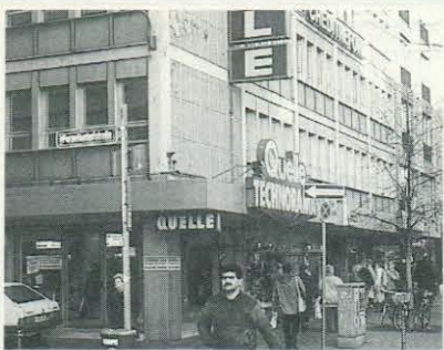
Zeil 46, am Rand der Fußgängerzone
