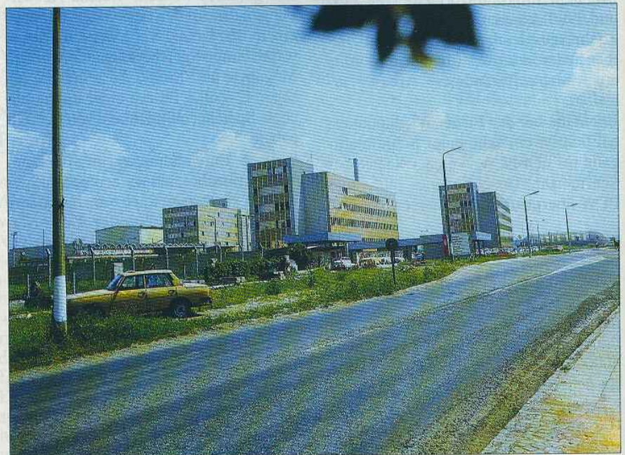
Ein Blick auf das Firmengelände der VEB Mikroelektronik
