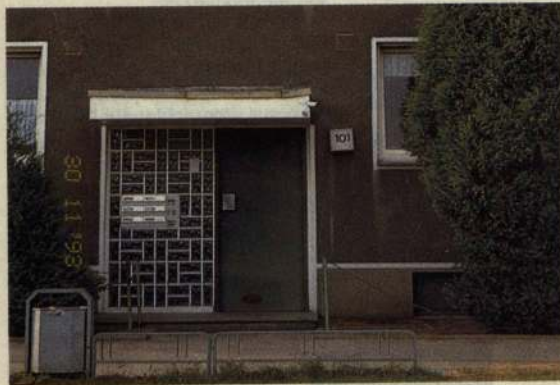
Die berühmterbüchtigte Tunnelstr. 101 in Gladbeck: ein älterer Mehrfamilien-Wohnblock
